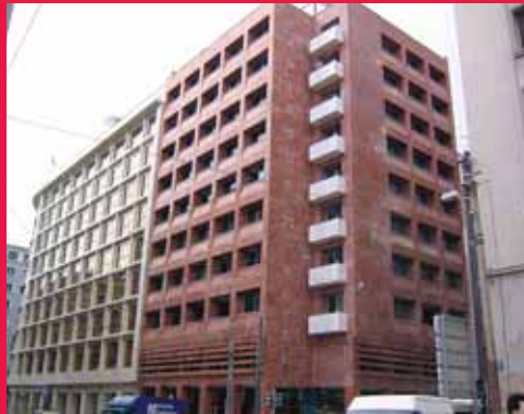
Seismische en brandwerende upgrade van hotel "Kaningos 21", Athene, Griekenland
