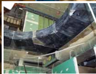
Upgrade van een cirkelvormige opening van het Park Palace Pronovias , Libanon
