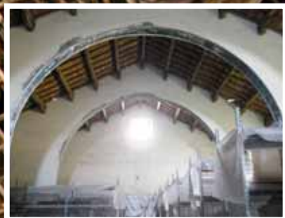
Versterken en reparatie van gemetselde gewelven , Toscane, Italië
