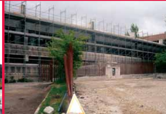
Constructieve reparatie en renovatie van het gerechtsgewouw (Tribunale) , Italië
