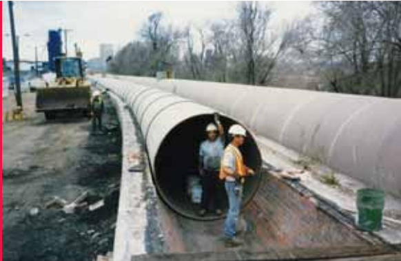
Constructief herstel middels TFS® voor Denver Water . Een grotendeels sleufloze oplossing bleek de beste optie
