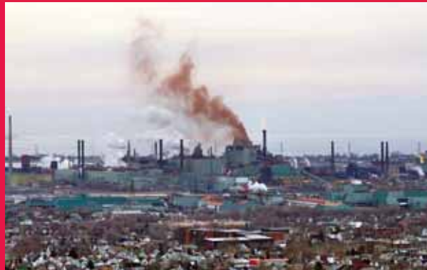
Noodreparatie van een gewapend beton koelwaterleiding met een diameter van 1,20m voor Arcelor Mittal Dofasco , Canada.
