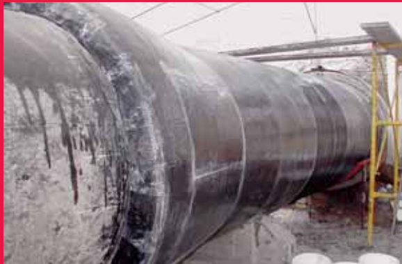
Noodreparatie van een gewapend beton hoofdwaterleiding van Water Supply (EYATH) in Thessaloniki, Griekenland
