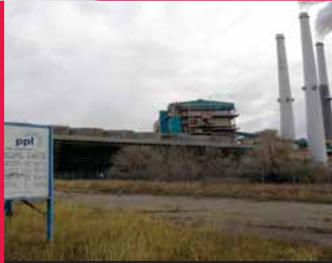
Renoveren en versterken van een gewapend beton leiding met een diameter van 1,80m en ca. 35m lang voor PPL Montana
