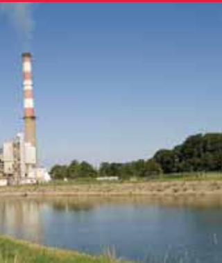
Noodreparatie van een stalen leiding met een diameter van 1,20m voor een energiecentrale
