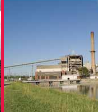
Renoveren en versterken van een diameter van 3,00m voor Dominion Pipe, Yorktown .
