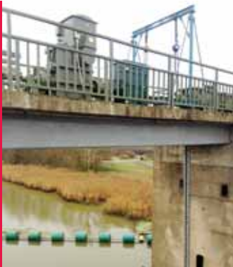
Constructie versterken van AG Wright Sluis, Denver , Norfolk, Verenigd Koninkrijk
