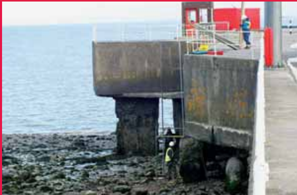
Reparatie en bescherming van steunpijlers tegen verdere erosie van de West Stub Pier , Bristol Port, UK
