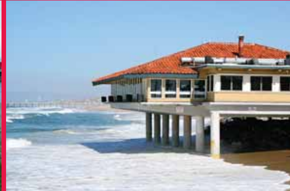
Constructieve renovatie en reparatie van Redondo Beach Restaurant , Californië, Verenigde Staten
